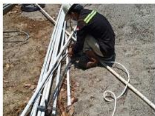
Fabrikasi PVC vent pipe
