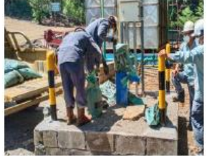
Proses memasukkan Coke Breeze ke Deepwell
