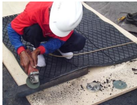
Cold Splicing di Lokasi atau di Lokasi/Workshop
