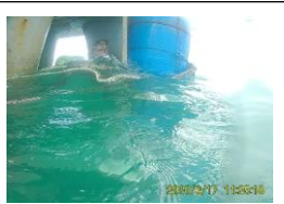
Membawa Matrial Ke Pile Yg dipasang
