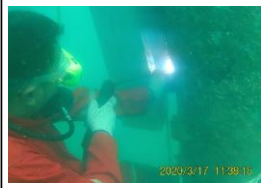
Pengelasan Anoda (Pull Weld)
