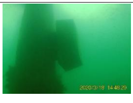
Posisi Anoda Setelah Terpasang
