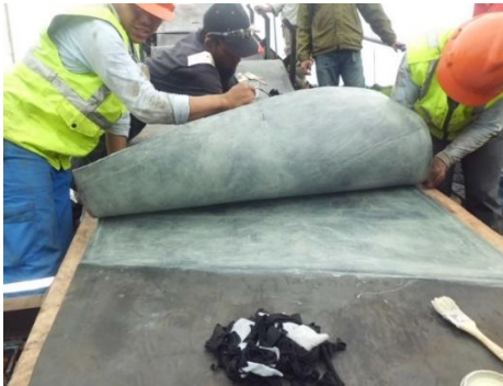
Cold Splicing di Lokasi atau di Lokasi/Workshop
