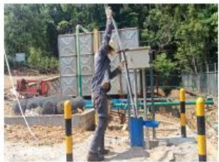
Instalasi MMO Anode
