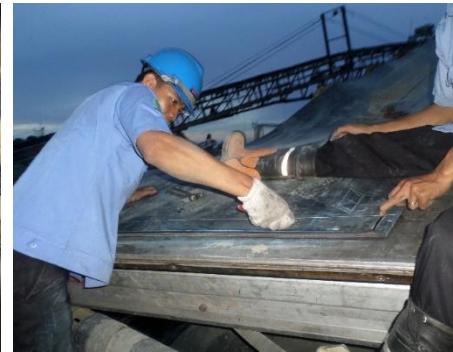
Hot Splicing di Lokasi atau di Lokasi/Workshop
