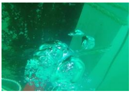
Posisi Anoda Setelah di press
