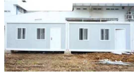
Feb 2026 - Detachable Modular - PT Binayasa Putrabatara - Karawang
